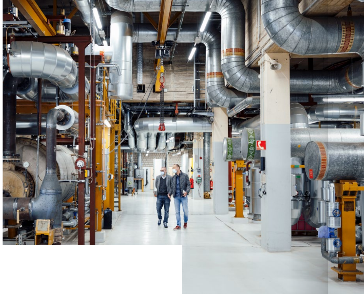
Die Energiezentrale der Universitätsmedizin Essen auf dem Campus Hufelandstraße
